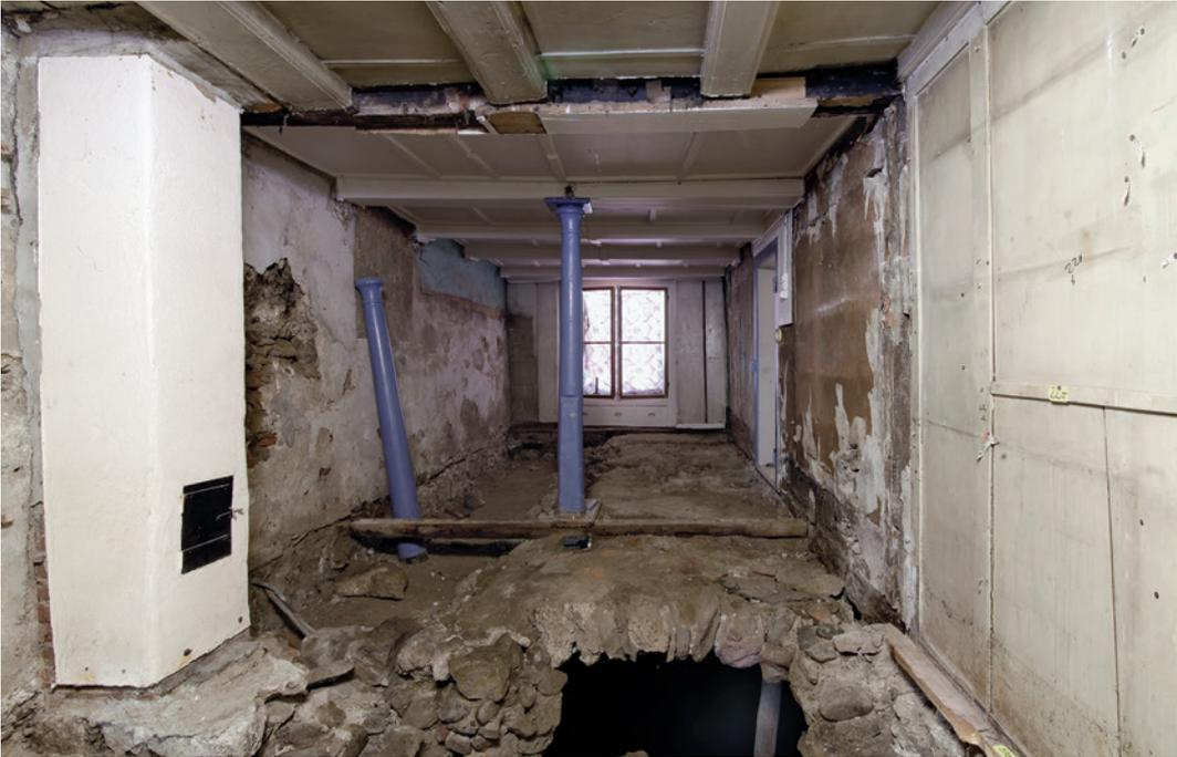
Abb. 5: Wiedlisbach, Städtli 29. Blick in die ehemalige Stube mit der unter dem Boden angeschnittenen Gewölbetonne des strassenseitigen Steinkellers 03 der Zeit um 1500. Blick nach Norden.
